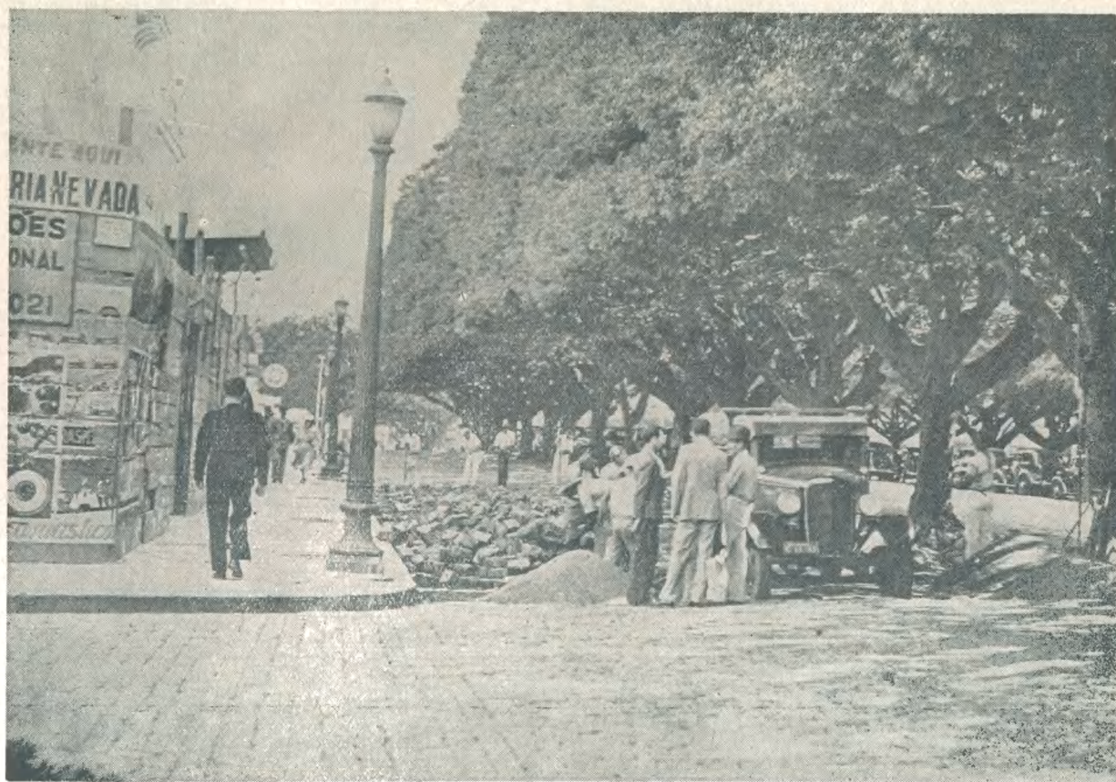
A AVENIDA AFONSO PENA TEVE O SEU CALÇAMENTO SUBSTITUÍDO. OS PARALELEPIPEDOS DERAM LUGAR À FAIXA DE ASFALTO
