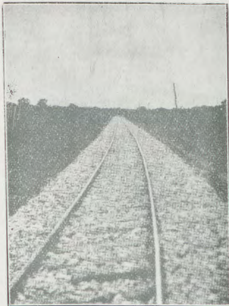
Empedramento da linha a partir do Km. 153(500, na Estrada de Ferro de Goiás
