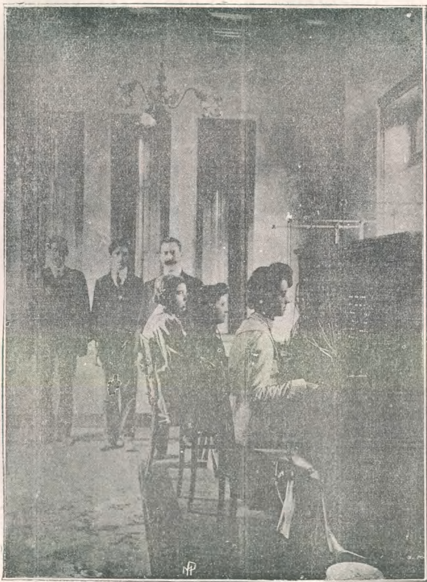
Interior do centro telephonico da Capital, depois das grandes reformas porque acaba de passar, feitos pelo actual prefeito, dr. Olyntho Meirelles.
