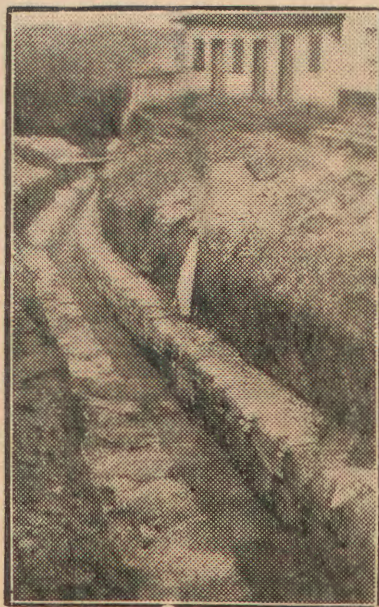
Esgoto em alvenaria de pedra e cimento, na Rua da Caridade.
