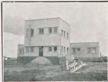
Casa dos Filtros do novo serviço de agua de Uberaba
