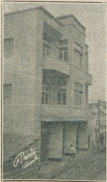
Edificio da Sociedade Rural do Triangulo Mineiro, em Uberaba.
