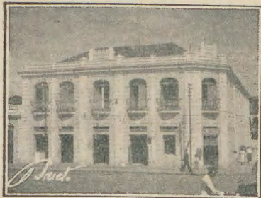
Vista da fachada do Hotel Modelo
