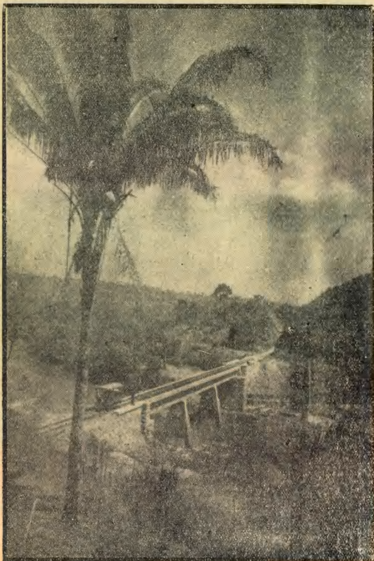
Um aspecto da ponte da R. M. V. entre os territórios de Minas e Goiás, extensa de 160 metros, e notável obra de engenharia, construída em concreto armado. Em baixo, a ponte do Rio das Perdizes
