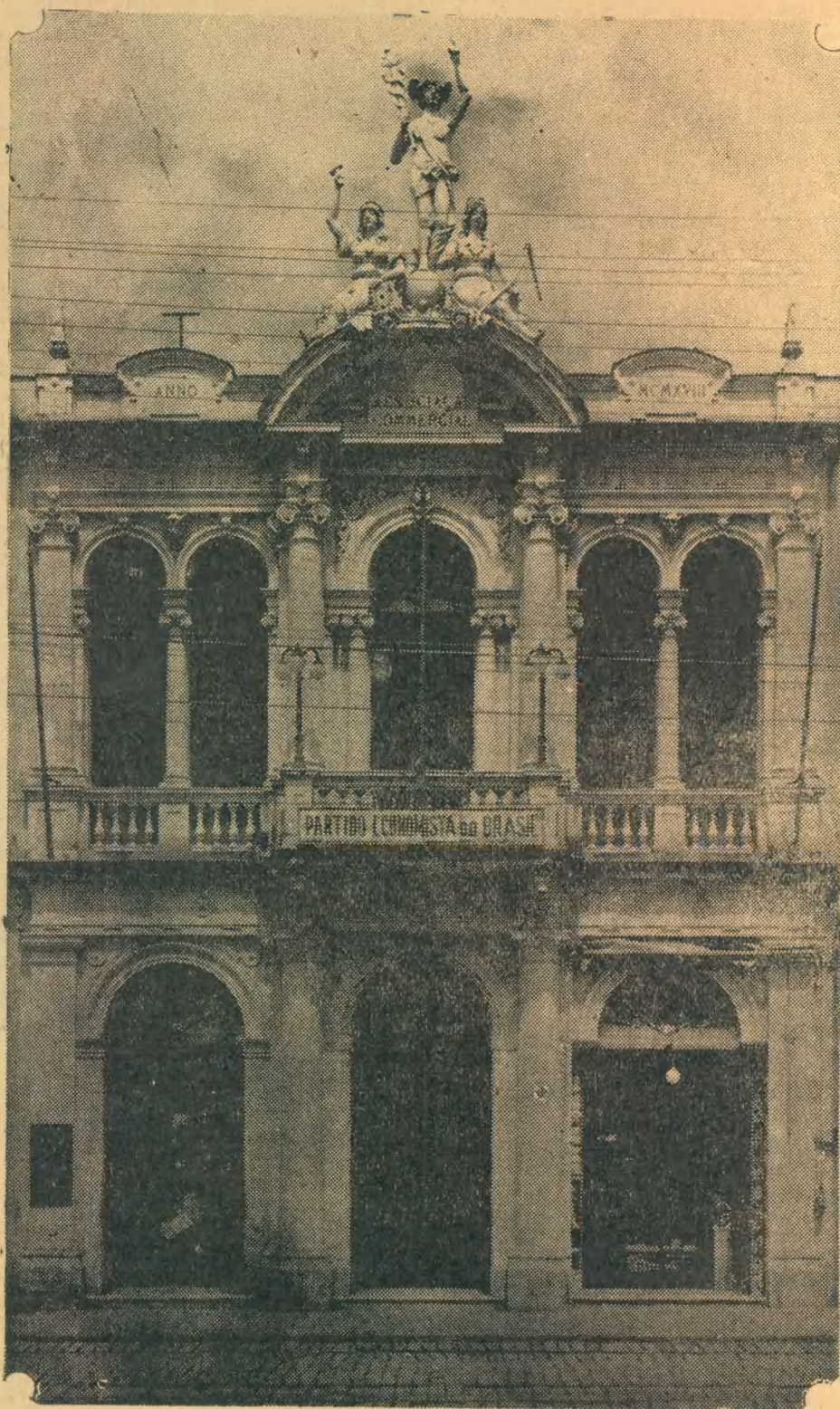
Edificio da Associação Commercial de Juiz de Fóra
