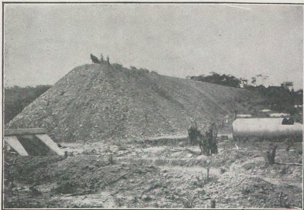
Ponta de um grande aterro sobre um boeiro.
