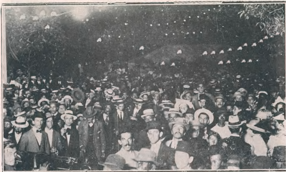
Aspecto da kermesse realizada em beneficio das obras da Capella da Boa Viagem.
