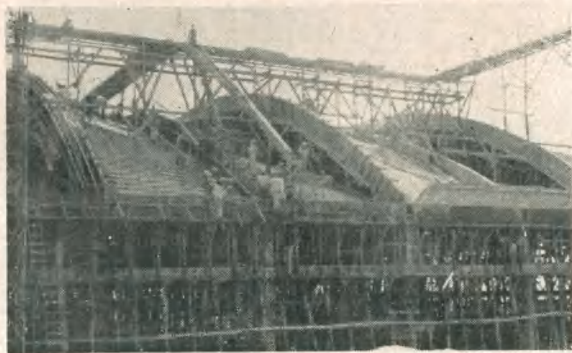
Armação dos arcos dos «sheds», do pavilhão n. 1
