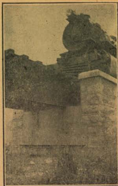
Aspecto feito no trecho Cumputuba. Ponte sobre o Ribeirão Vermelho, com 10 metros de vão.
