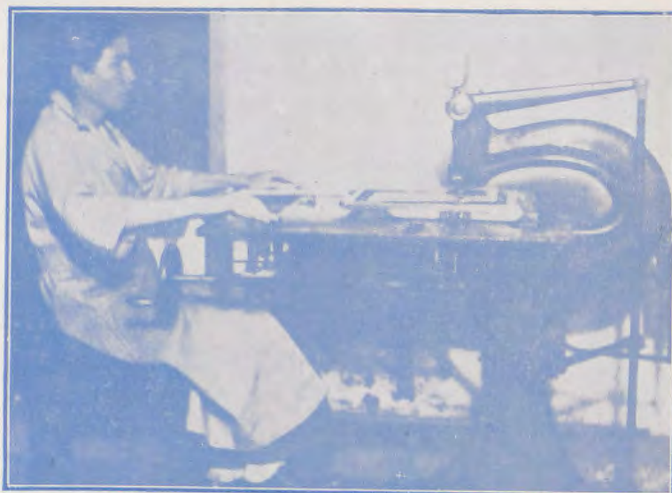
Um cego compondo na linotipo adaptada ao sistema Braille
