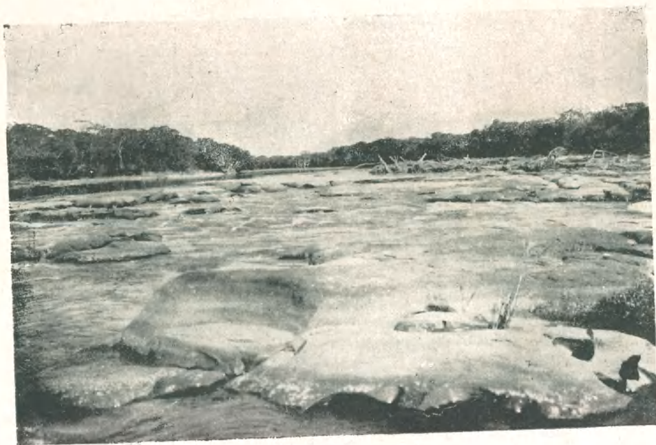
NO NORTE DE MINAS — Rio Urucuya. Corredeira do Poço Fundo. — Cerca de 2500 H P; a 18 k. do Porto da Manga.
