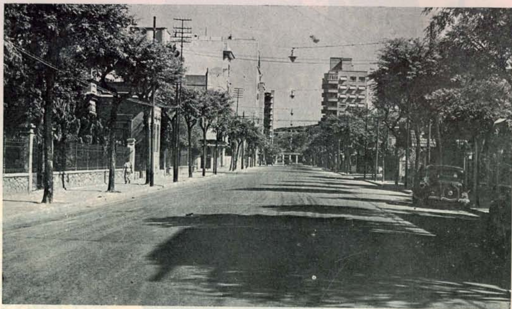
Um aspecto do lençol asfaltico so're base de concreto, na rua Copacabana
